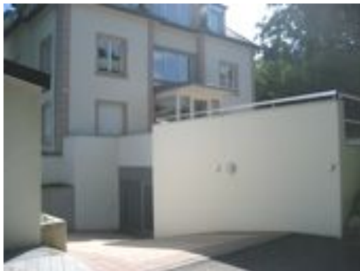
Garage und Tiefgarageneinfahrt
